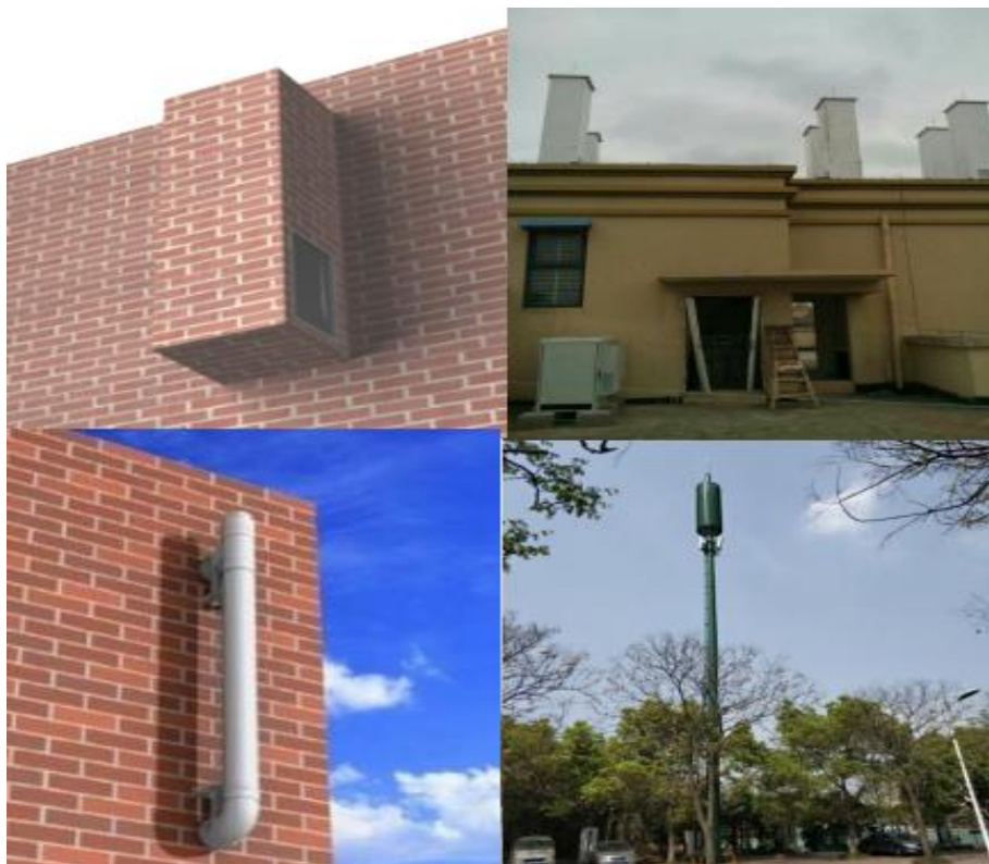
图 2.5-4 居民小区基站建设方案示意图
